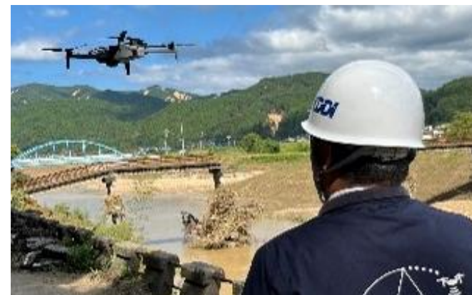
ドローンによる被災状況の確認
